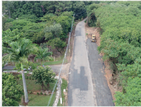
Obras de reparo na Josefina Giovana Rossi: operação tapa-buracos, limpeza, sinalização e melhorias no acostamento.
