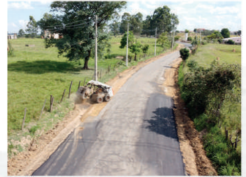
Obras de reparo na Josefina Giovana Rossi: operação tapa-buracos, limpeza, sinalização e melhorias no acostamento.
