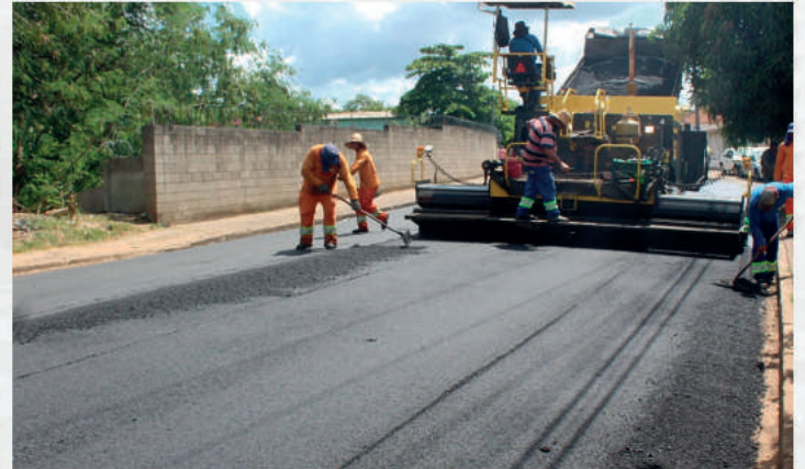
Recapeamento asfáltico nos bairros Moreto e Jardim Santo Antônio.
