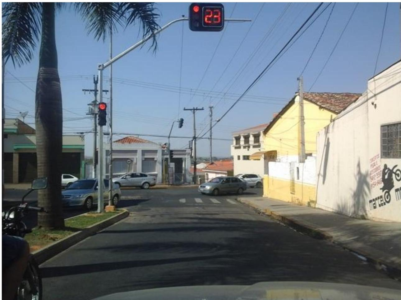
FOTO 07: Semáforo em bom estado de conservação, porém este cruzamento tem um grande problema de falta de visibilidade por construções sem recuo.
