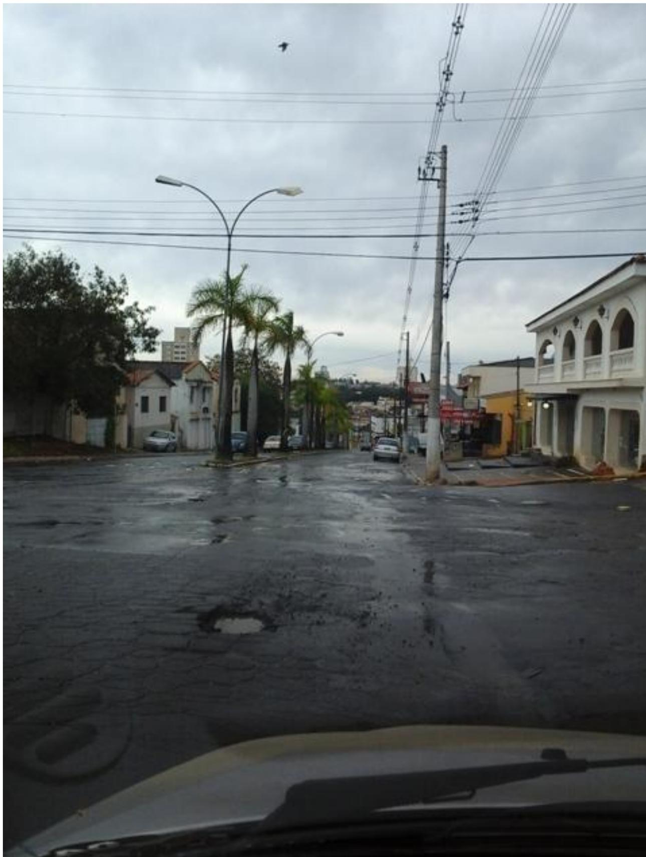
**FOTO 28:** Entrada da cidade, necessidade de recape, pois o pavimento existente não está compatível com o tráfego recebido.
