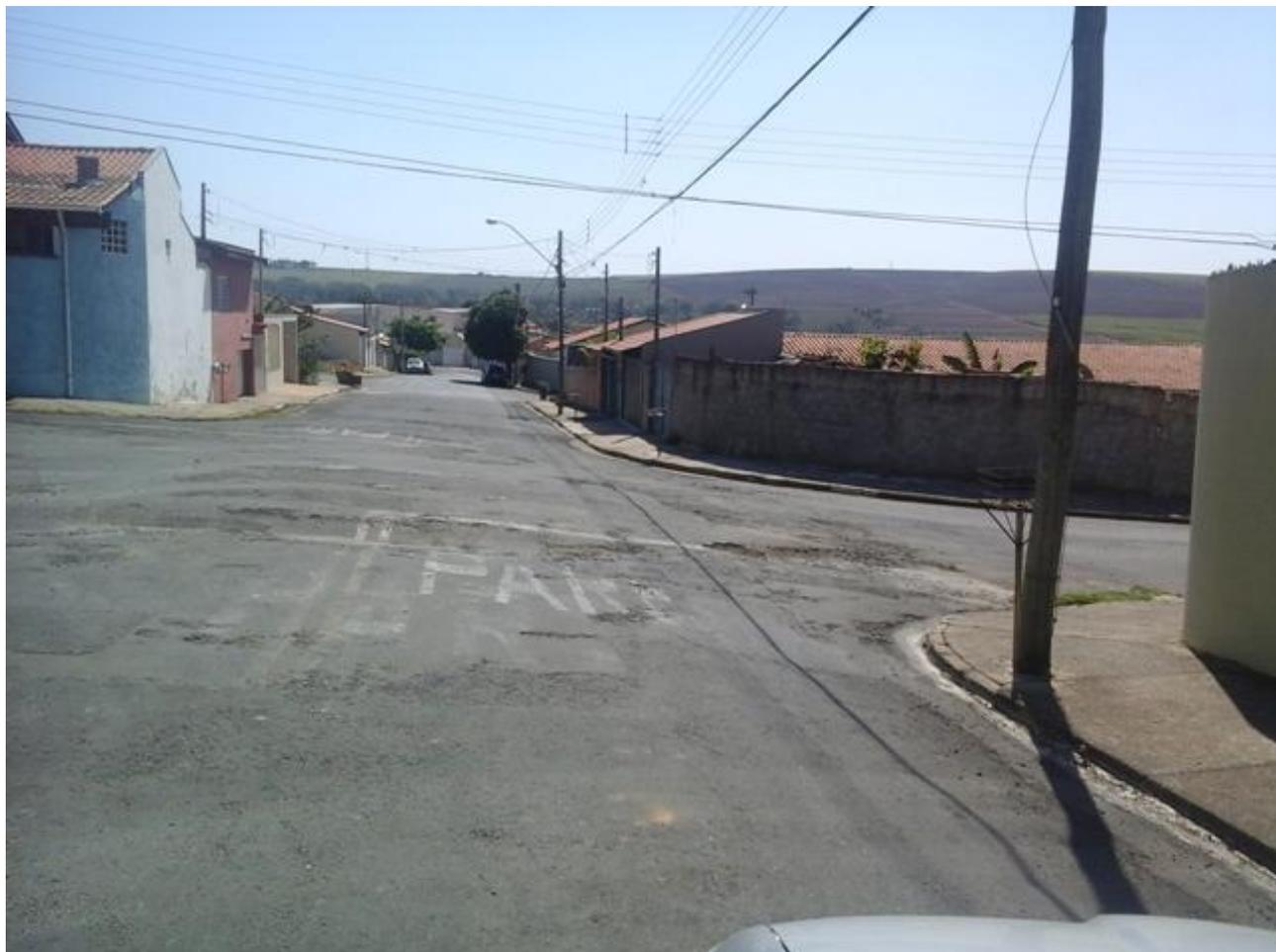
**FOTO 23:** Situação crítica do asfalto velho, pouco espesso com perda de materiais, necessitando recapeando(grande parte da cidade).
