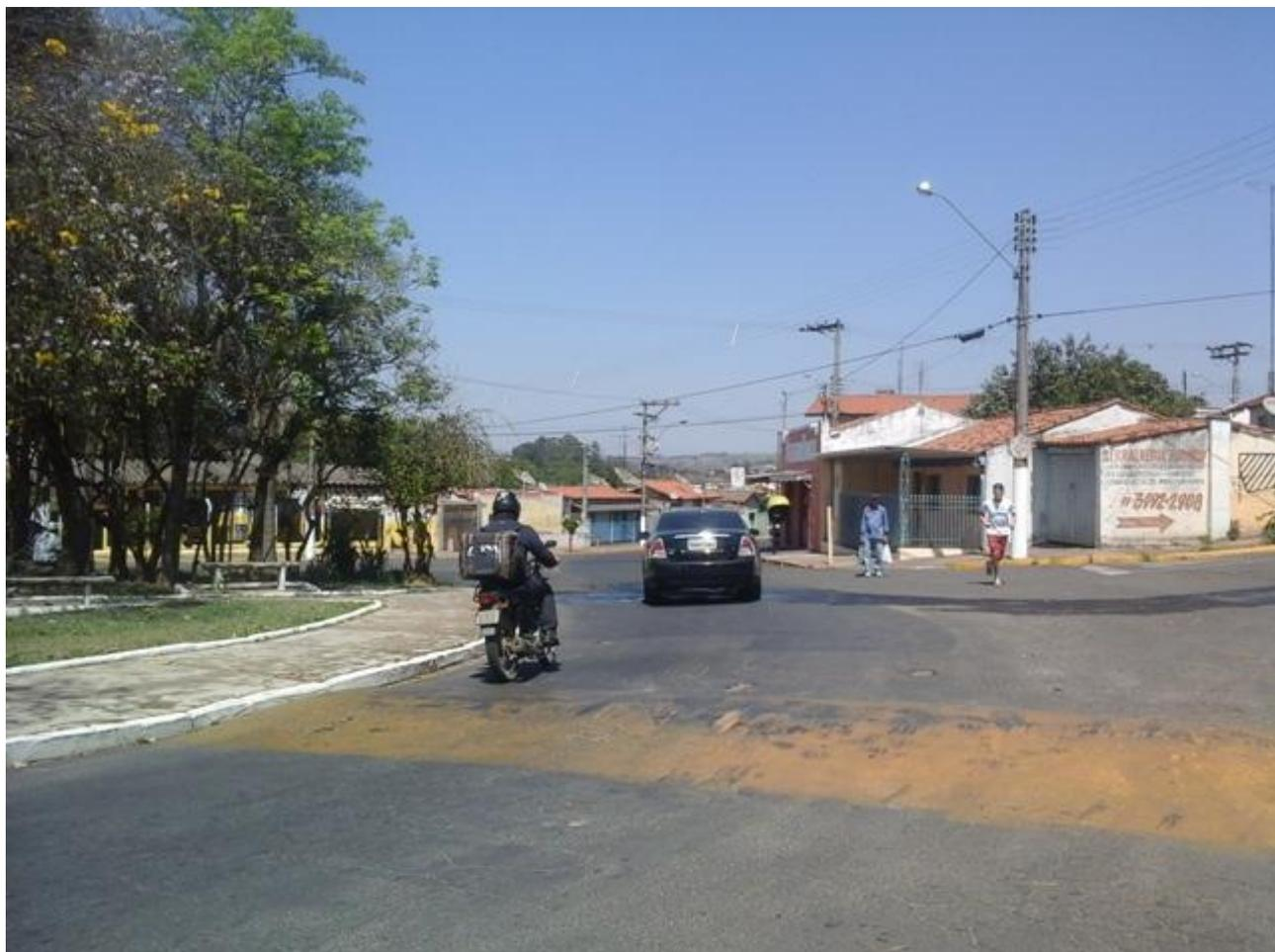
**FOTO 11:** Lombada totalmente em desacordo com o estabelecido no CONTRAN, pois além do excesso em altura, está com a sinalização desgastada e construída em curva (totalmente proibido).
