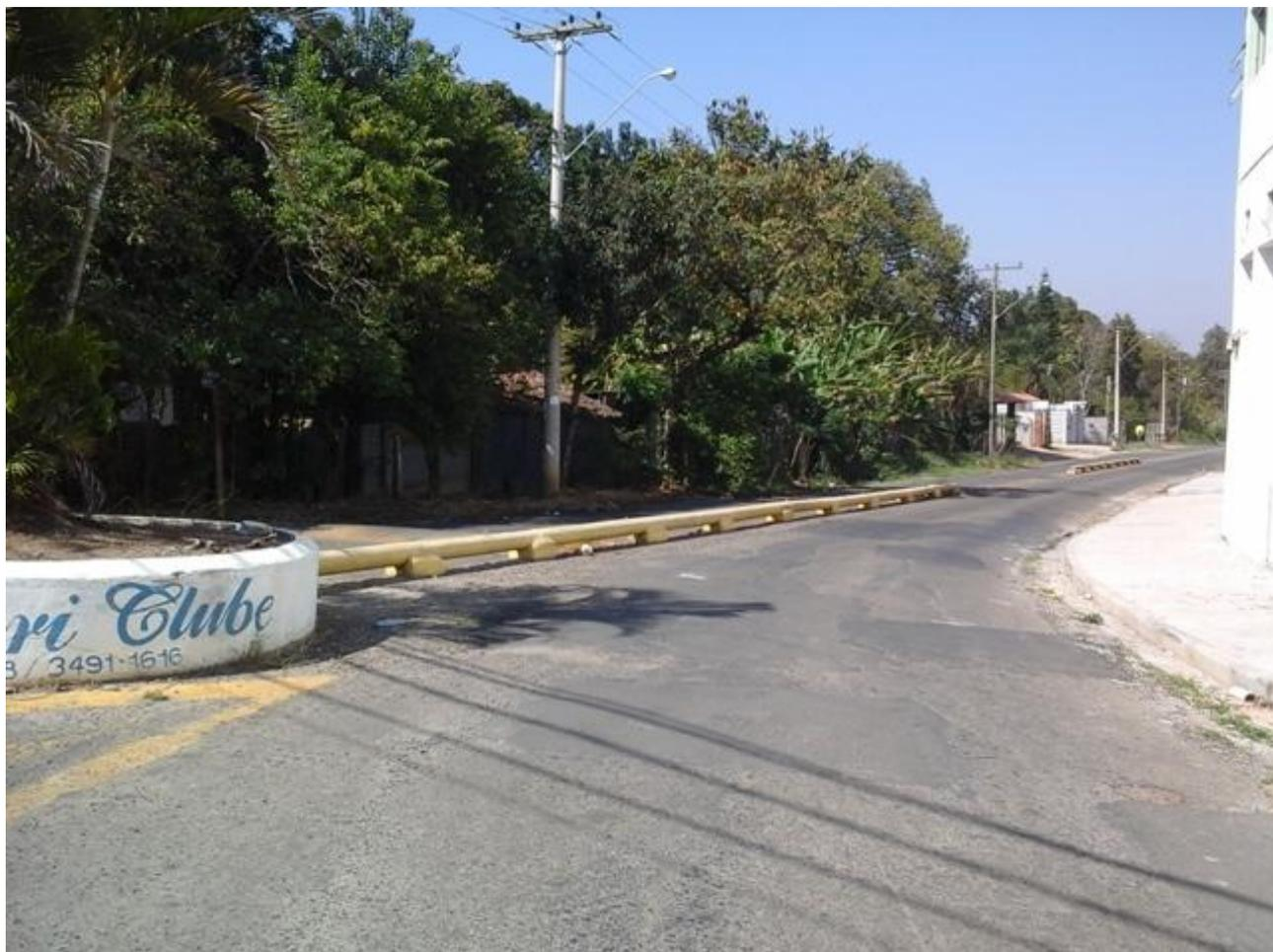
**FOTO 16:** Dispositivo utilizado em desacordo com o estabelecido no CONTRAN, que pode causar sérios acidentes, principalmente com ciclistas e motociclistas.
