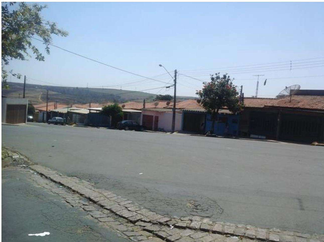
**FOTO 18:** Situação crítica criada pelo excesso de largura e falta de dispositivos geométricos e de sinalização.
