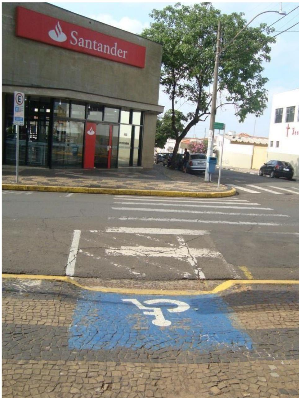
**AI-01 - Necessidade de complementação dos rebaixamentos, conforme a NBR 9050**
