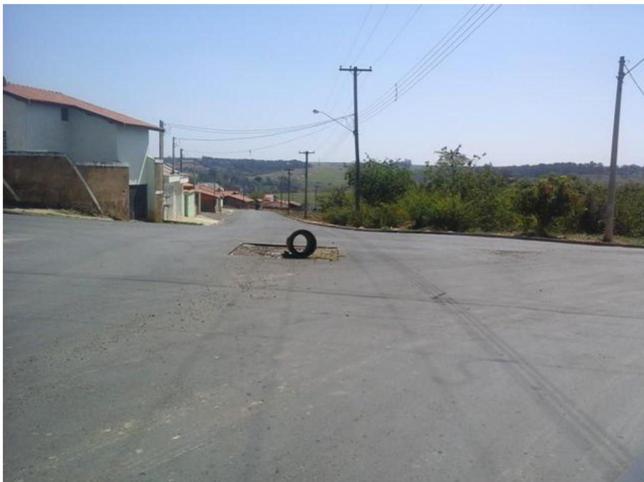
**FOTO 27:** Situação análoga a anterior, porém com maior gravidade, pois está no centro do cruzamento, sendo que a noite o risco de acidente é aumentado pela falta de sinalização noturna de obra.
