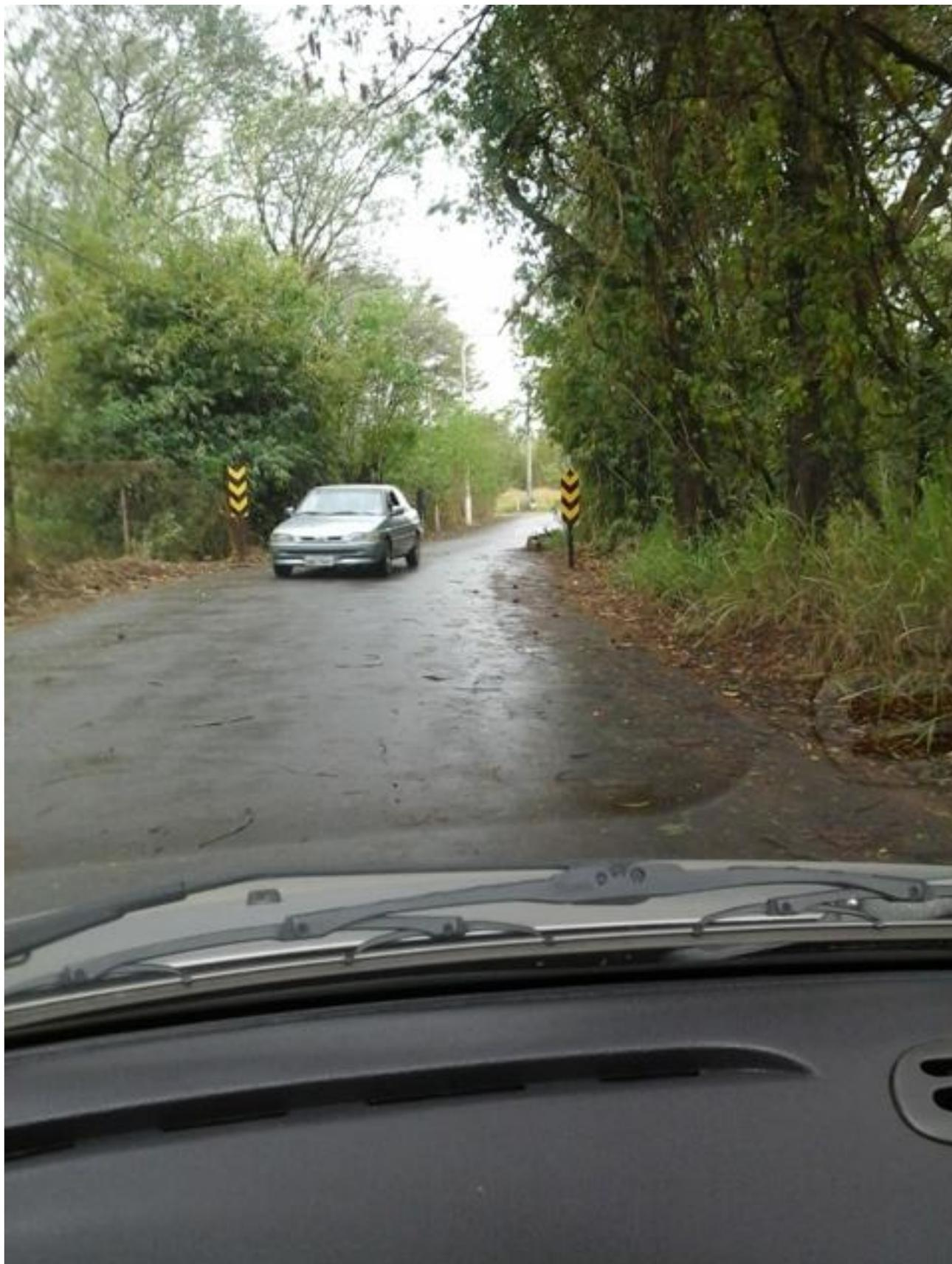
**FOTO 44:** Risco de colisão, pois a ponte estreita esta localizada logo após a curva.
