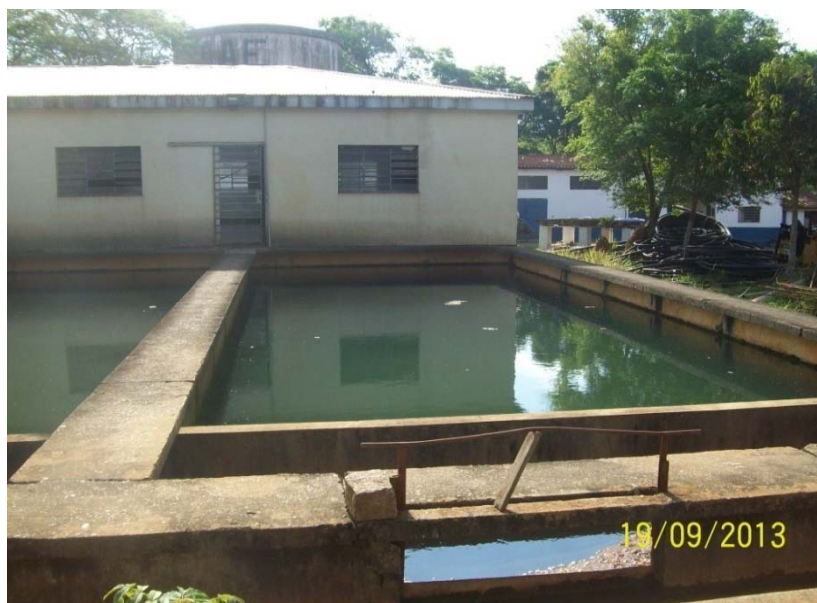
Foto 5 – ETA I – Vista dos dois decantadores. Ao fundo a edificação que abriga a sala de comando e os filtros.
