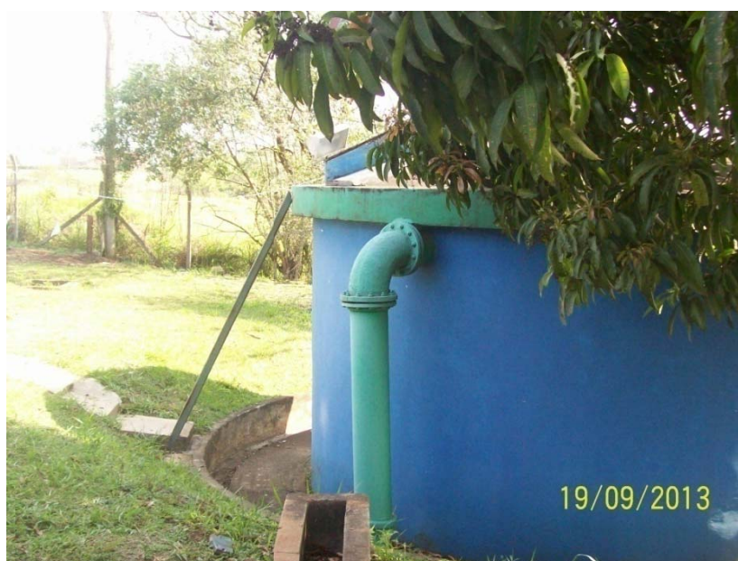
Foto 25 – ETA II - Vista do reservatório de 100 m 3
