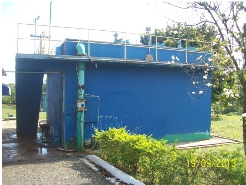
Foto 20 – ETA II - Módulo de tratamento de água.
