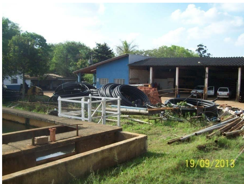
Foto 6 – ETA I - Vista de um módulo de decantação - existência de área anexa para futuras ampliações
