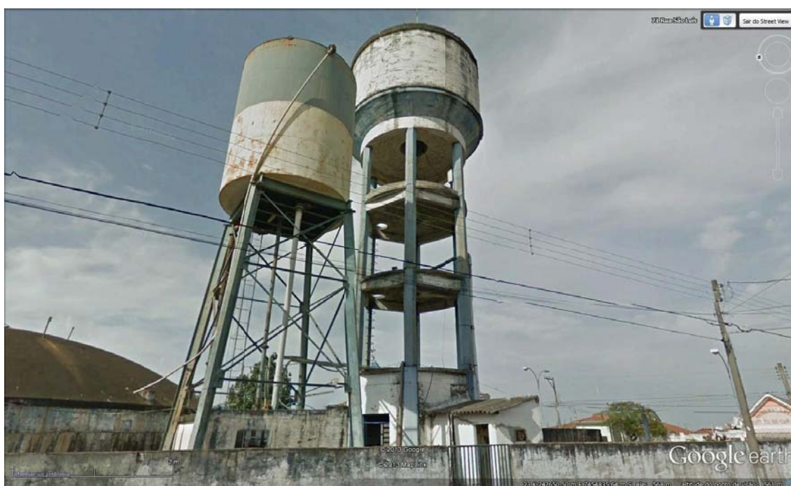
Foto 33 – Centro de Reservação Pio XII, ao fundo, à esquerda, o reservatório semienterrado de 100 m³. Imagem obtida pelo Google Earth.
