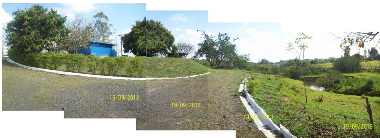
Foto 14 – ETA II - Vista geral
