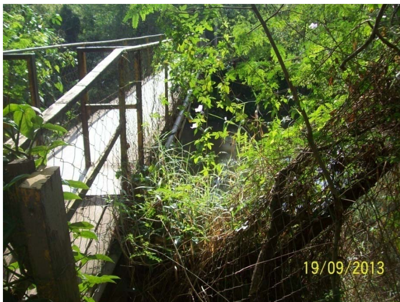
Foto 1 – ETA I -Adutora de água bruta - Córrego Engenho Velho-Travessia junto à passarela.
