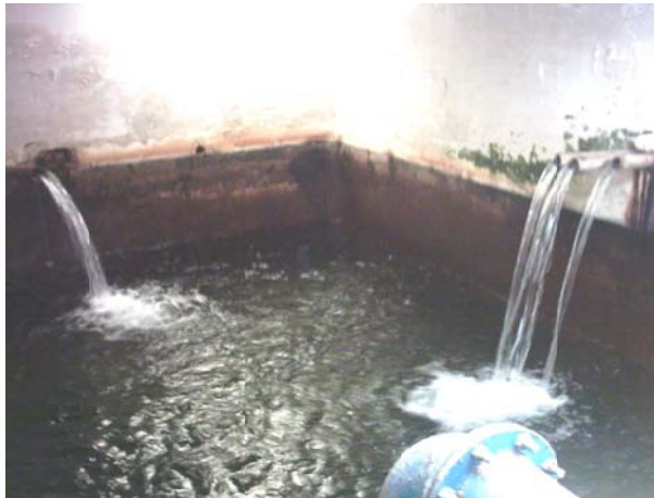
Foto 34 – Vista interna do Reservatório do Subsistema do Caraça
