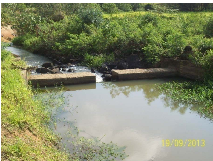
Foto 17 – ETA II - Barragem de alteamento de nível no Ribeirão Água Choca
