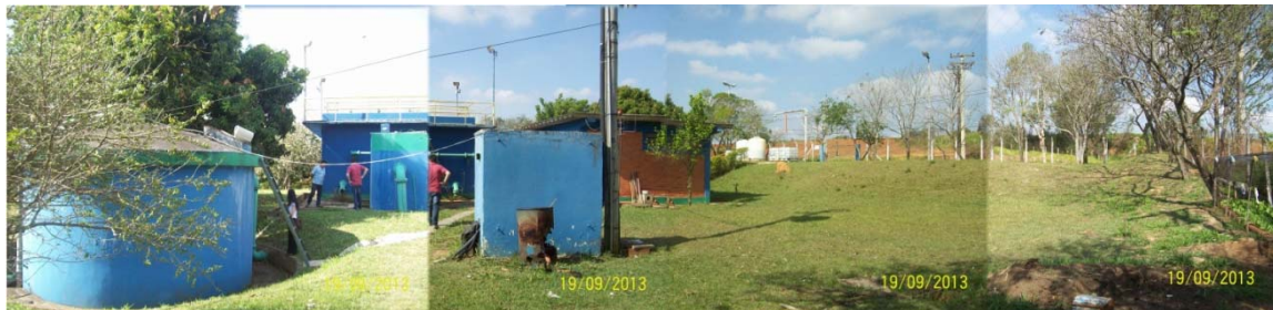
Foto 13 – ETA II - Vista geral
