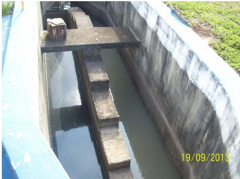
Foto 3 – ETE Porto Alegre - Passagem do esgoto sanitário e "stop log" à frente
