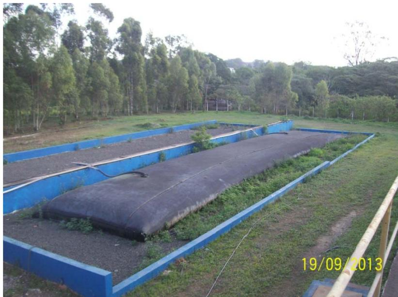
Foto 14 – ETE Porto Alegre - “Bag” do sistema de desidratação do lodo gerado pelo tratamento, nota-se que o “bag” apresenta boa drenagem nas laterais.
