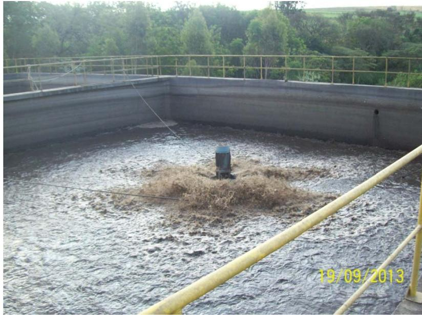
Foto 7 – ETE Porto Alegre - Visão do tanque de aeração com aerador central, fluxo ascendente e eixo vertical.
